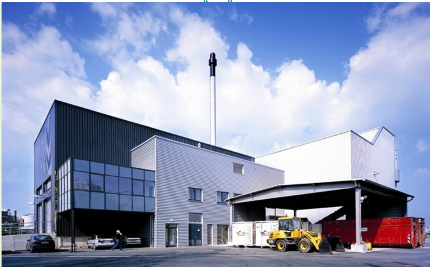
Zakład pirolitycznego rozkładu odpadów komunalnych Minden (Niemcy)
