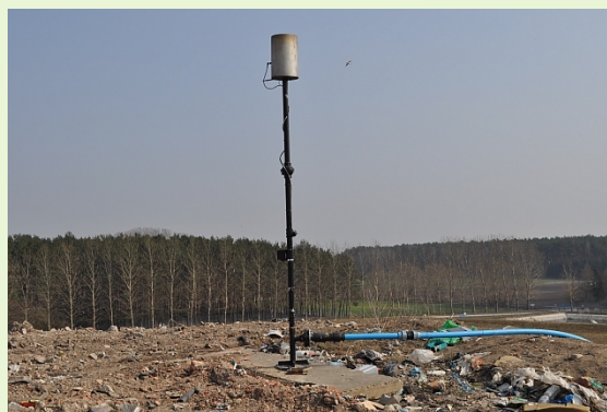
Odgazowanie składowiska śmieci
