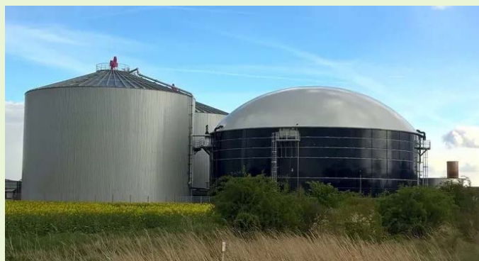
Biogazownia ze świńskiej gnojowicy
