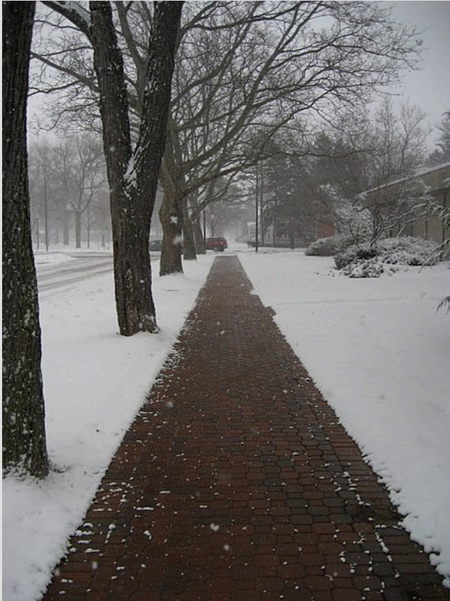
INSTALACJE TOPNIENIA ŚNIEGU (podjazdy, mosty, drogi, chodniki)
