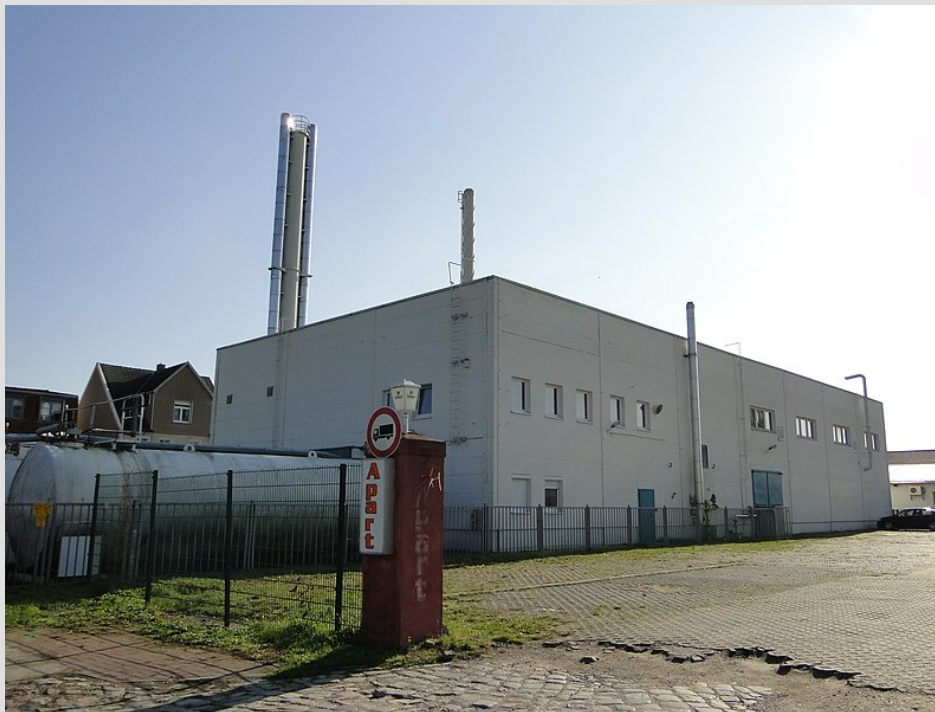
GEOTERMISCHE HEIZZENTRALE NEUBRANDENBURG
