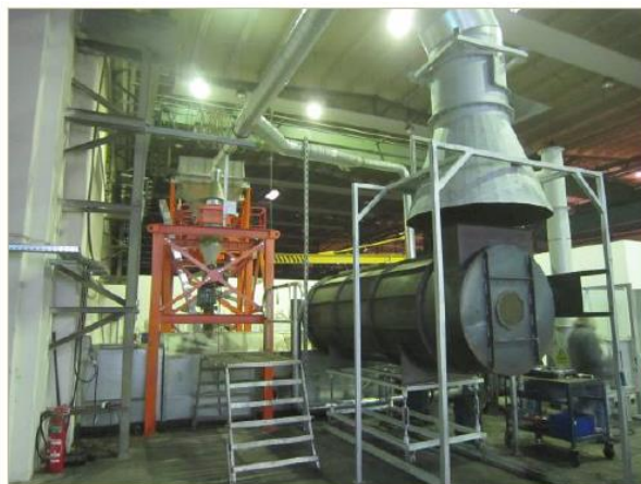
Rys. 16 Zakład pirolitycznego rozkładu odpadów MEE-Anlage Schwerin (Niemcy)
