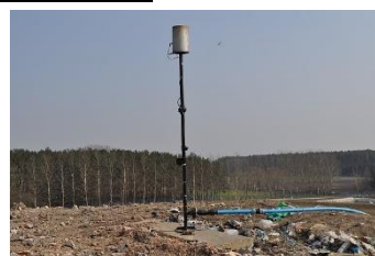
Odgazowanie składowiska śmieci
