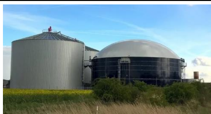
Biogazownia ze świńskiej gnojowicy
