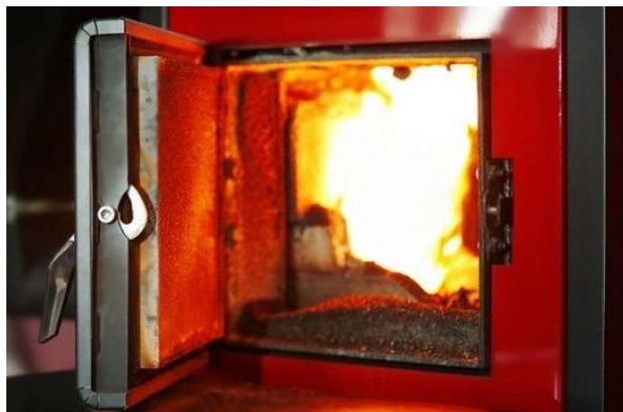
Rys. 10 Palenisko kotła
