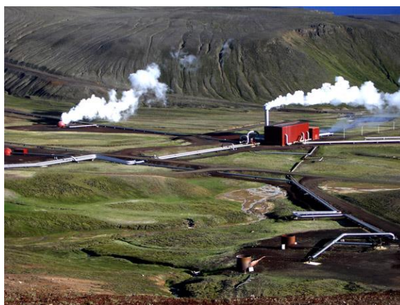
Rys. 25 ELEKTROWNIA GEOTERMALNA KRAFLA (ISLANDIA)
