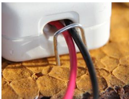
Stabilizowanie kabli zszywkami zrobionymi ze spinaczy biurowych
